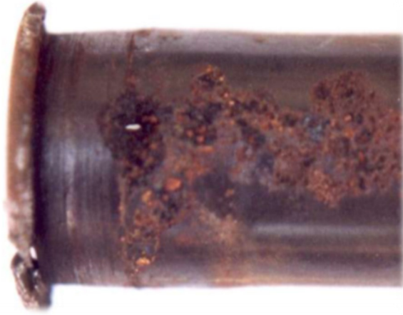
Şekil 11. Çelik boru malzemedeki çukurcuk korozyonu.
