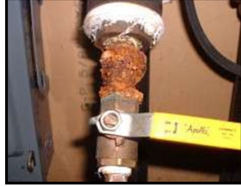
Şekil 3. Boru bağlantı bölgelerinde galvanik korozyon
